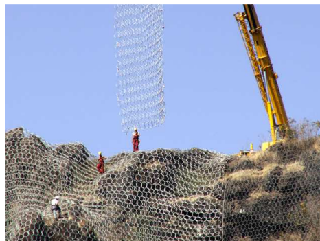
Pose de filets de protection sur le chantier du viaduc de Saint-Paul - Route des Tamarins.
